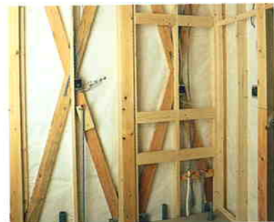
①施工前 電気配線・配管のセット。在来の壁はコーナーの入墨に下地材を取付け、床下の通気を止めた後、作業を開始します。
