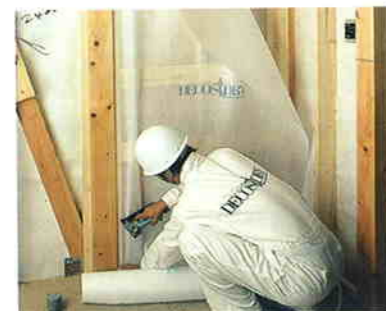
②デコスシート施工 縦張りを基本とし、土台から胴差しまで弛みのないように張ります。
