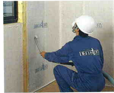
③ブローイング 施工密度 55±5kg/m 3 ホースを挿入し、専用施工機からブローで風送。均一に隙間なく、丁寧にブローイングします。
