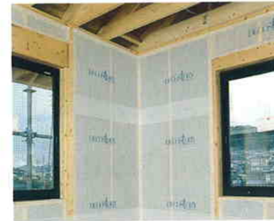
④施工完了 振動による沈降試験[経年による沈降は認められない] (財)建材試験センター/依試 第7H66404号
