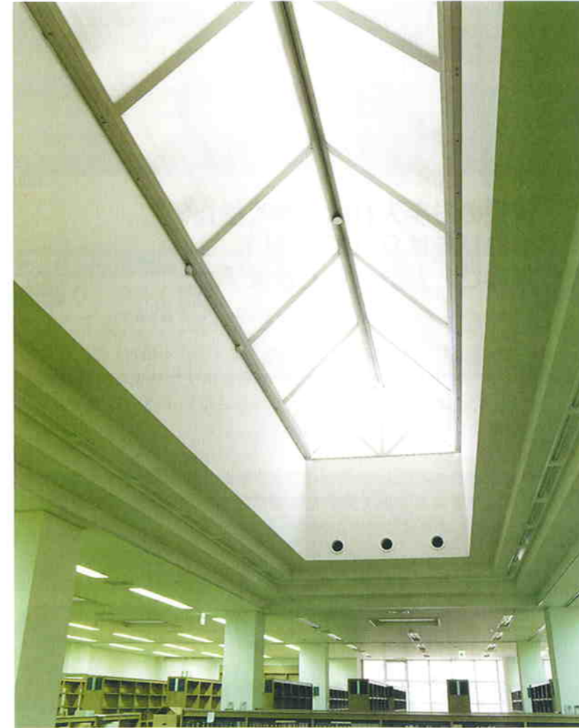
公立図書館 天窗(傾斜面)施工例
