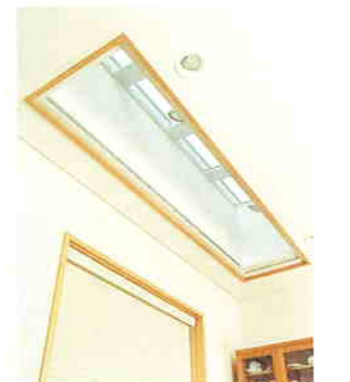
一般住宅施工例
